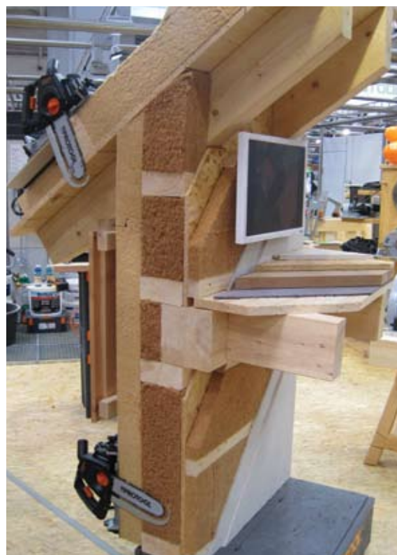
Стена экодома в разрезе
