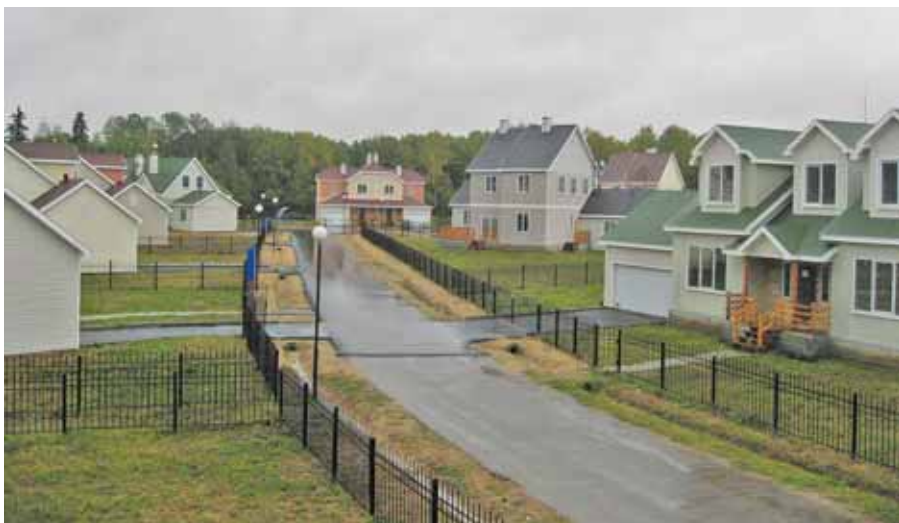
■ Поселок, возведенный по объемно-модульной технологии
