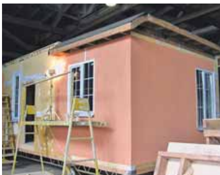
■ Отделка фасада декоративной штукатуркой
