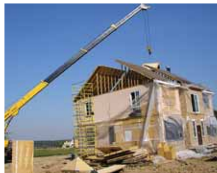
■ Монтаж здания из модулей
